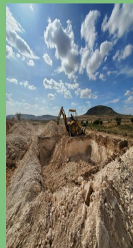
CONSTRUCCIÓN DE LAGUNA DE OXIDACIÓN EN EL HINOJO
